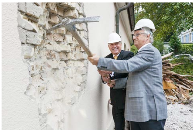
Ueli Gerber und Rolf Büttiker geben den Startschuss für den Abbruch.
