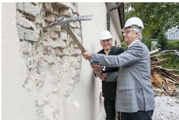
Ueli Gerber et Rolf Büttiker donnent le «premier coup de pioche» pour la démolition.
